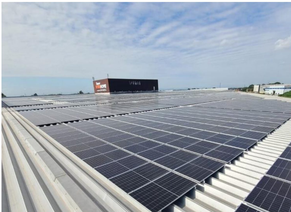
※スーパービバホーム加須店屋根上設置状況
