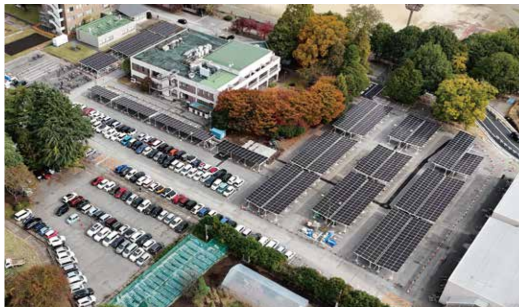
宇都宮大学にて設置工事のカーポートの一部
